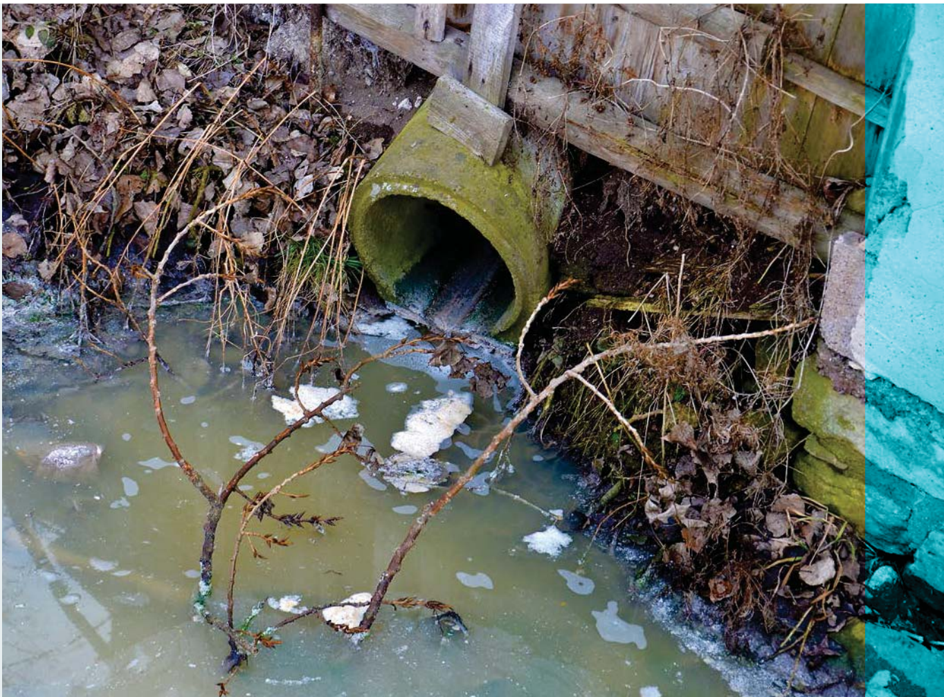
Abb. 2: Teilortskanal. Quelle: Jörg Londong
